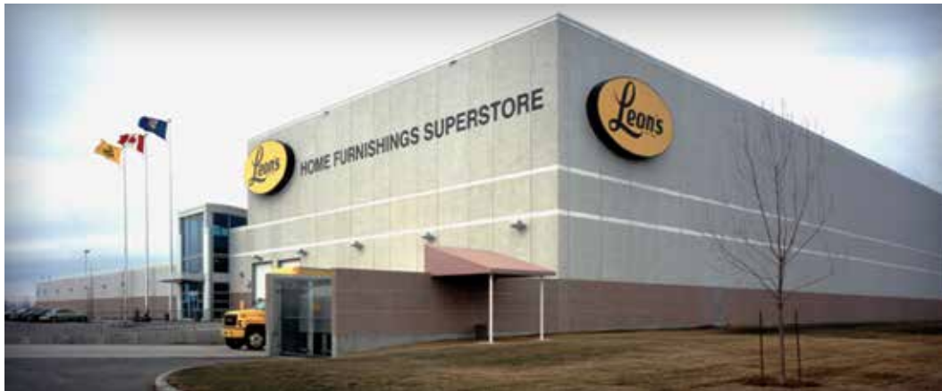
Meubles Léon • Edmonton AB • Murphy Hilgers Architects
